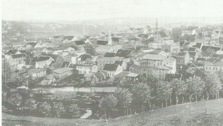
Na zdjęciu: Widok Koronowa z 1905 roku
