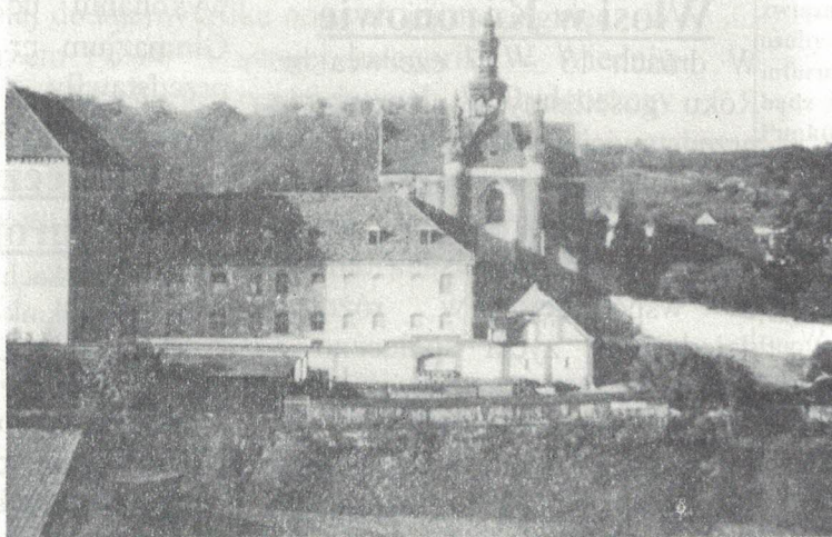
Kościół i zabudowania Klasztoru zamienione na więzienie - rok 1931
